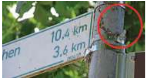
Hier ist der Wegweiser nach Osnabrück abgebrochen, gesehen an zwei Stellen in Bersenbrück
